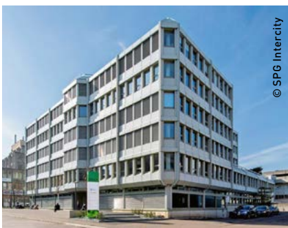
Die Liegenschaft an der Buckhauserstrasse in Zürich-Altstetten
